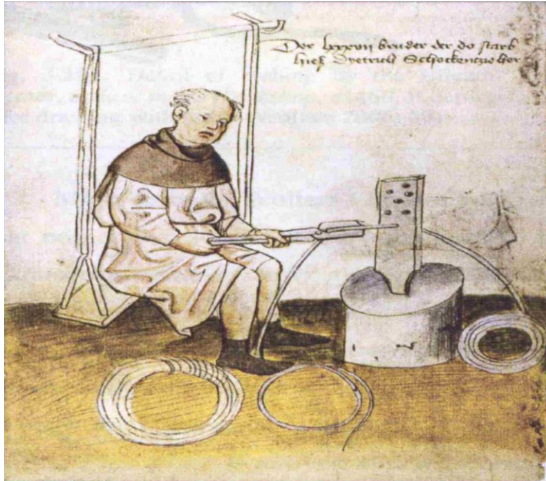
Slika 5: Prva ilustracija proizvodnje žice tehnikom izvlačenja [22]
