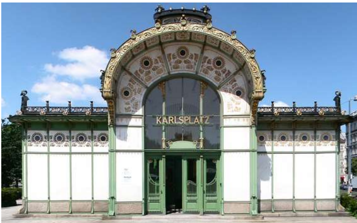
Slika 8. Željeznička stanica, Beč
