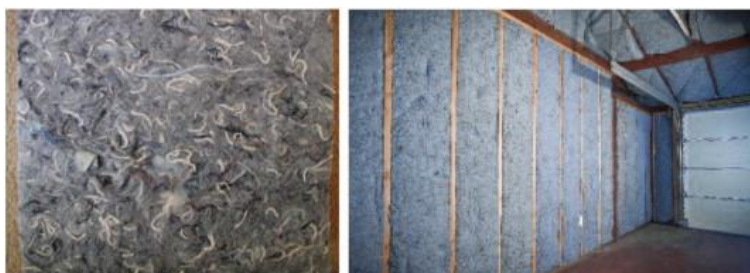
Slika 2.4.3.3. Panel od recikliranog pamuka (lijevo) i denim (desno) [24].
