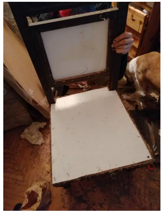
Slika 28: Rezanje šperploče po mjeri za naslon i sjedalo
