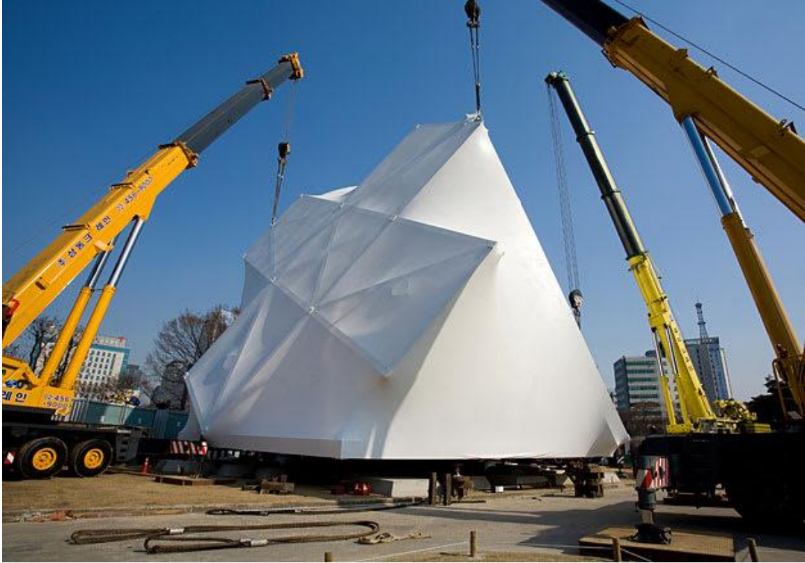
Sl.19. Prada Transformer, Seoul, 2009.
