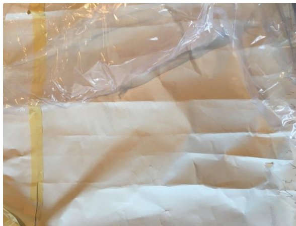
Slika 13. Krojenje folije prema predlošku
