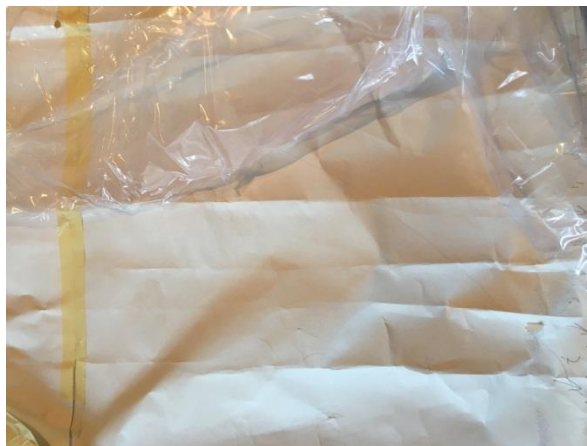
Slika 13. Krojenje folije prema predlošku
