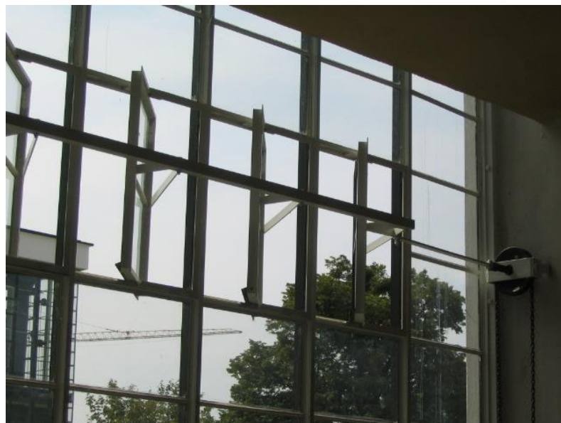
Slika 6: Mehanizam za otvaranje prozora – Bauhaus, Dessau
