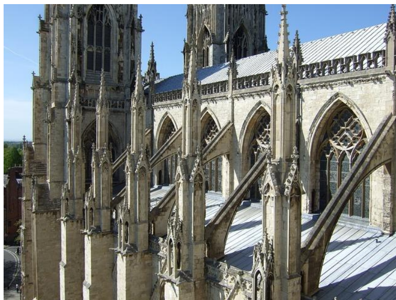
Slika 4. - Leteći kontrafori katedrale u Yorku
