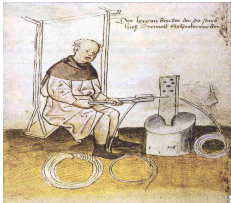
Slika 5: Prva ilustracija proizvodnje žice tehnikom izvlačenja [22]
