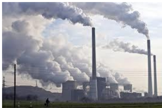
Slika 11. Tuzlanska termoelektrana (BIH)
