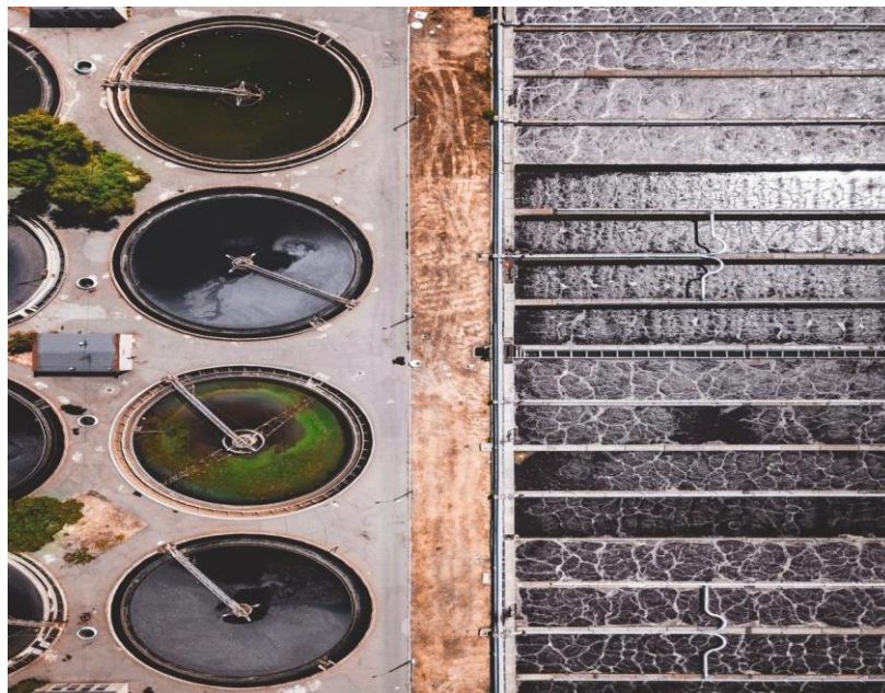
Sl. 3. Prikaz bazena s otpadnim vodama [7]
